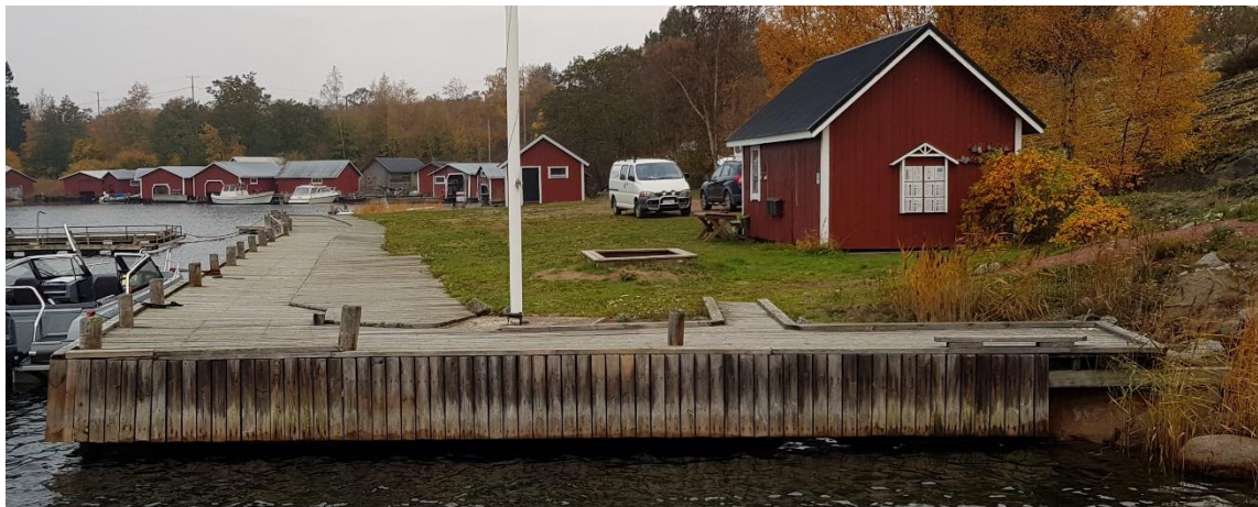
Bild 3. Inre kajen och befintligt hamnkontor.
